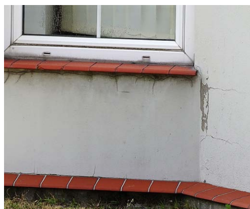
Rys. 1. Przykłady pleśni i wykwitów z życia wzięte
