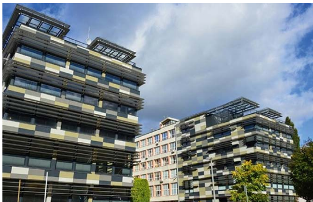
Rys. 1. Przykład elewacji wykończonej okładzinami z blach (źródło: Wydział Elektroniki i Technik Informatycznych Politechniki Warszawskiej)
