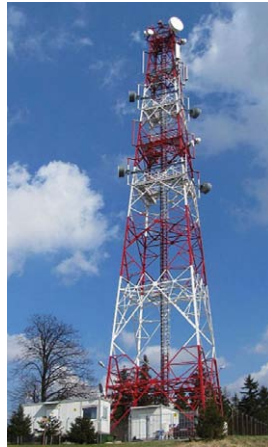
Rys. 6. Anteny na wieży telekomunikacyjnej
