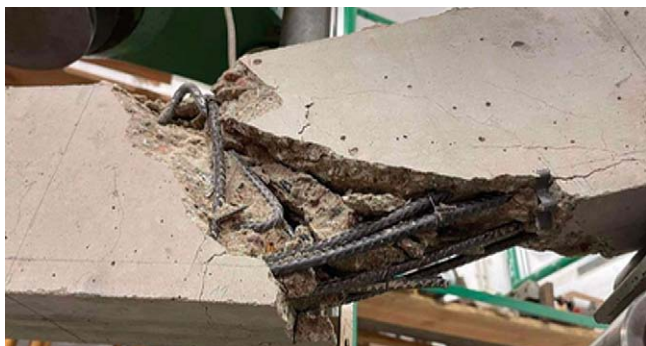
Rys. 7. Obraz zniszczenia belki 1
