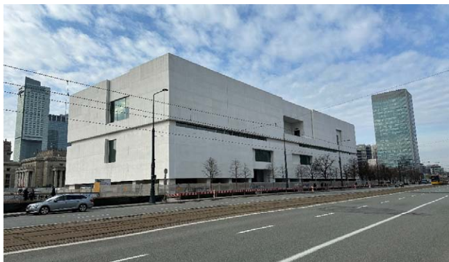
Rys. 1. Budynek Muzeum Sztuki Nowoczesnej w Warszawie wykonany z białego betonu architektonicznego (materiały własne)
