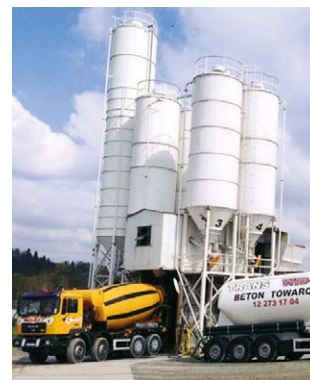
Rys. 5. Nowoczesny węzeł betoniarski z urządzeniami odpylającymi
