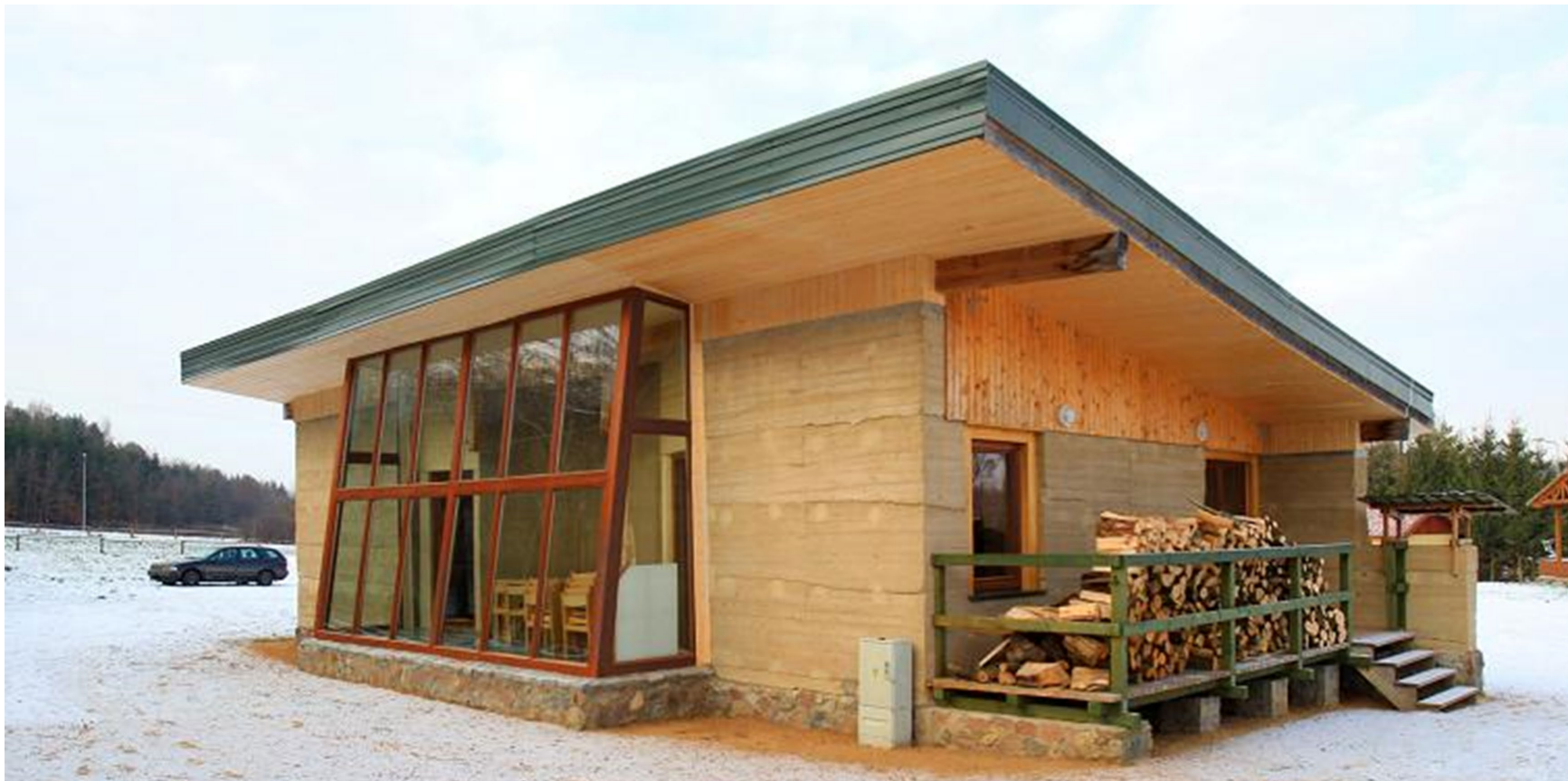
Budynek doświadczalny Politechniki Warszawskiej z ziemi ubijanej
