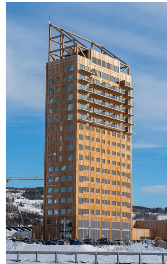
Mjostarnet - Najwyższy na świecie drewniany wieżowiec został zbudowany w norweskim mieście Brumunddal. Ma 18 pięter i 85 metrów wysokości.
