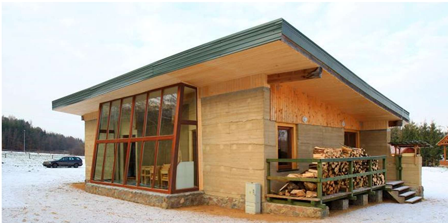
Budynek doświadczalny Politechniki Warszawskiej z ziemi ubijanej
